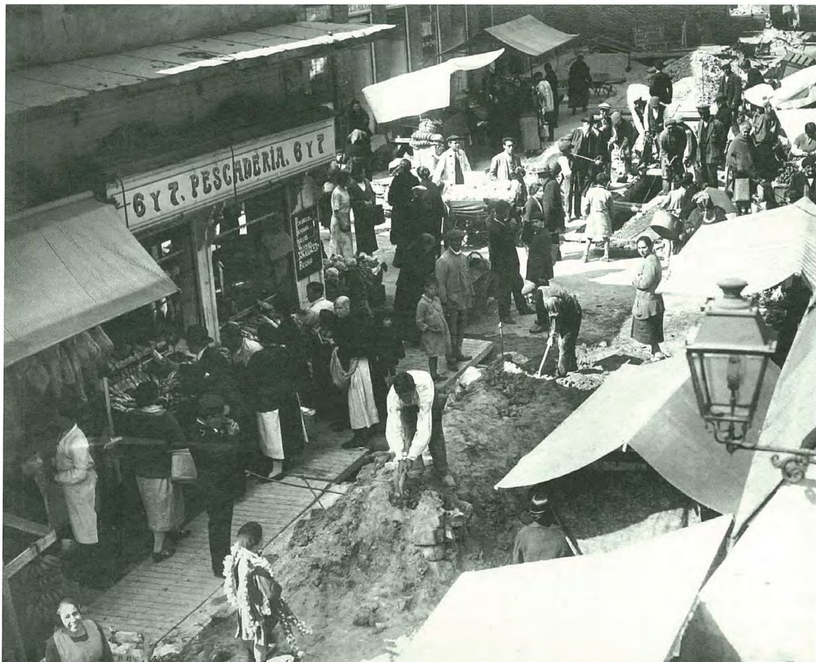
Obreros haciendo la canalización para la Compañía Telefónica Nacional en la calle Augusto Figueroa de Madrid Madrid, (192?) Fundación F. Largo Caballero
