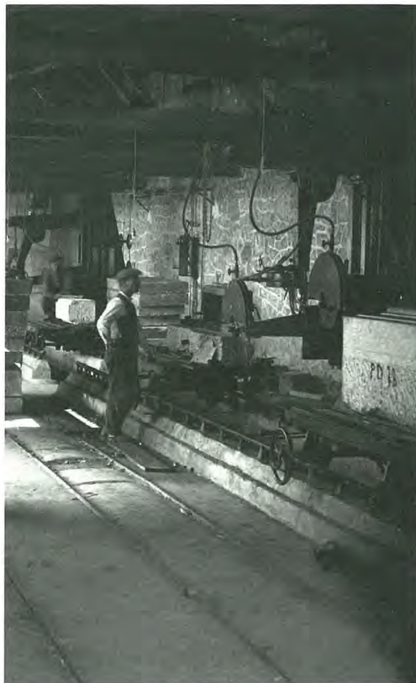
Obreros en un taller de cantería labrando piedra para el edificio de Gran Vía de Telefónica Madrid, (1922) Fundación F. Largo Caballero
