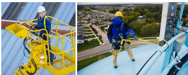
Figura 10. Trabajos en plataformas en altura y trabajos cerca de bordes
