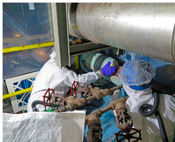
Figura 3. Trabajos de retirada de amianto friable, calorifugado de tubería, utilizando cerramiento con extracción.
