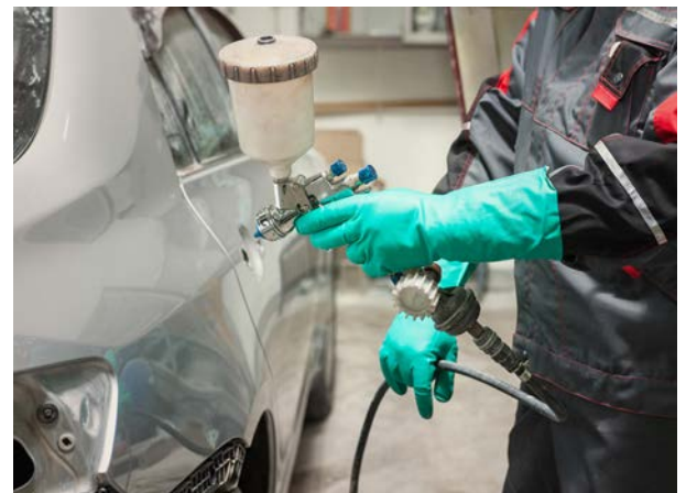
Figura 3. Situación con alta probabilidad de carga por exposición del EPI a nieblas de aerosol.
