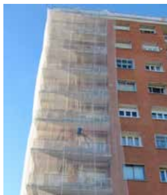
Figura 9. Instalación de una red de protección.
