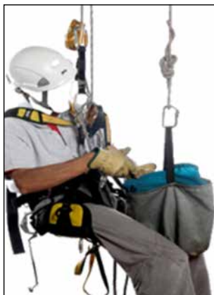
Figura 7. Abastecimiento asistido con cuerda auxiliar.
