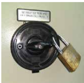
Figura 6. Bloqueo de un seccionador mediante candado.
