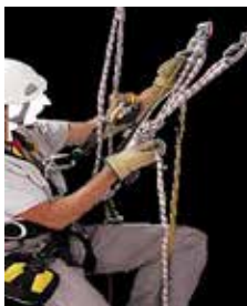
Figura 10. Fraccionamiento sobre un paramento vertical en posición de descenso.
