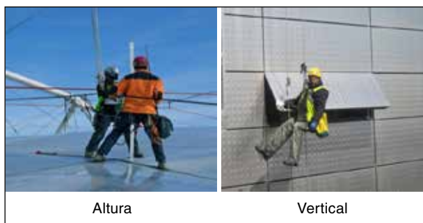
Figura 1. Ejemplo de trabajo en altura y vertical.
