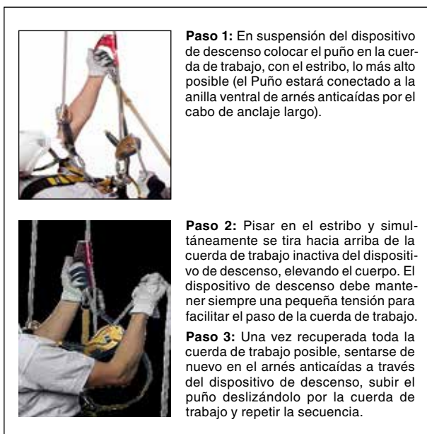
Figura 5. Técnica de descenso mediante dispositivo de descenso y bloqueador de ascenso tipo puño.
