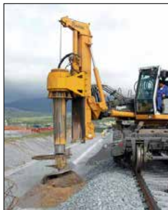
Figura 4. Ejecución de macizos
