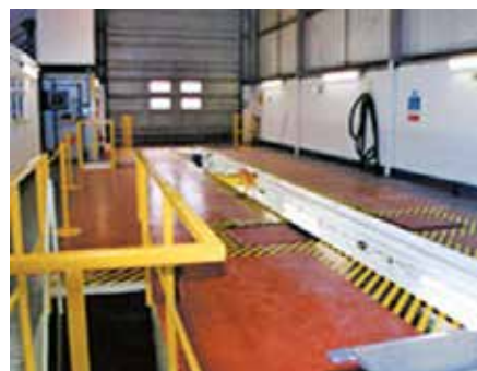
Figura 2. Escalera de acceso lateral
