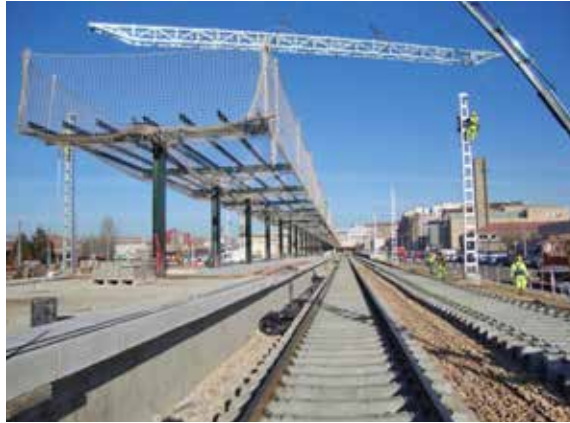
Figura 6. Colocación de pórtico.
