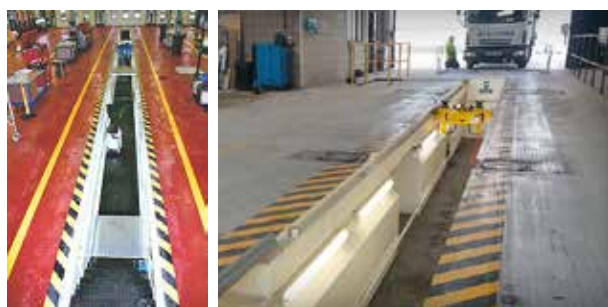
Figura 1. Foso de inspección de vehículos
