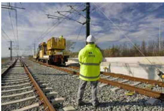
Figura 9. Montaje de aisladores.
