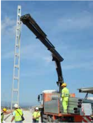
Figura 5. Colocación de poste.
