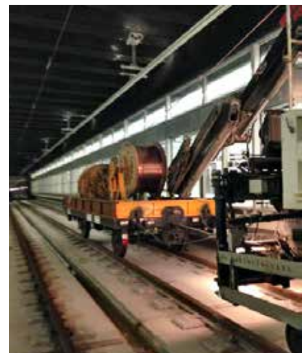
Figura 10. Tendido de conductores.
