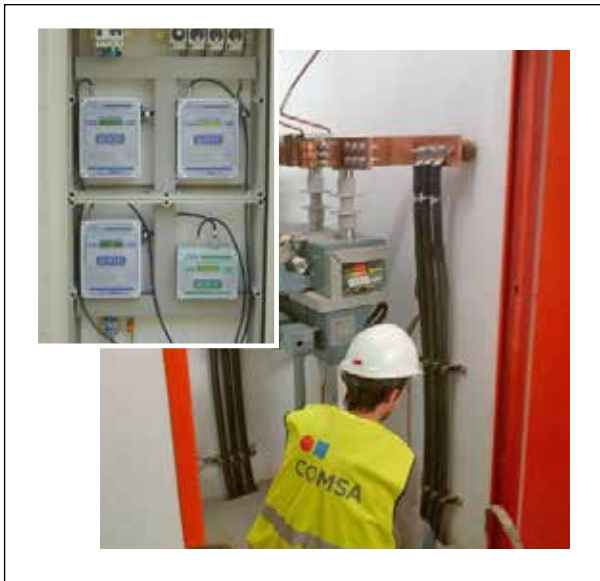
Figura 11. Ejecución de instalaciones de armarios eléctricos.
