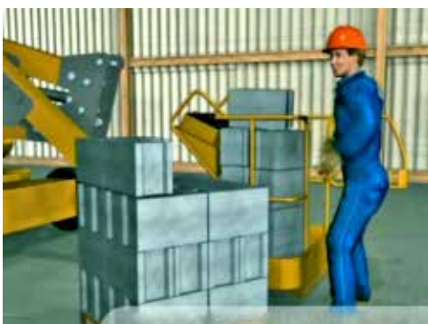
Figura 17. Plataforma de trabajo sobrecargada.
