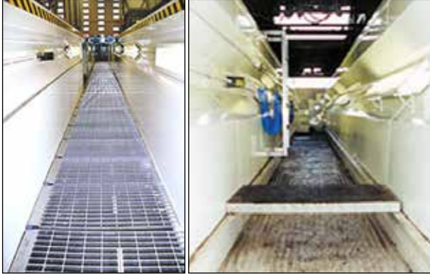
Figura 8. Superficie del foso de plancha perforada antideslizante.
