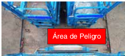
Figura 14. Zona de peligro de atrapamiento.
