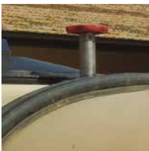
Figura 14. Dispositivo de vaciado del depósito.
