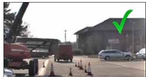
Figura 20. Delimitación de zona de trabajo.
