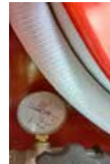
Detalle de BIE de manguera SEMIRÍGIDA: puede utilizarse sin desenrollarla por completo
