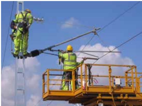
Figura 8. Montaje de ménsulas.
