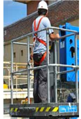
Figura 18. Operario con arnés y eslinga ajustable.
