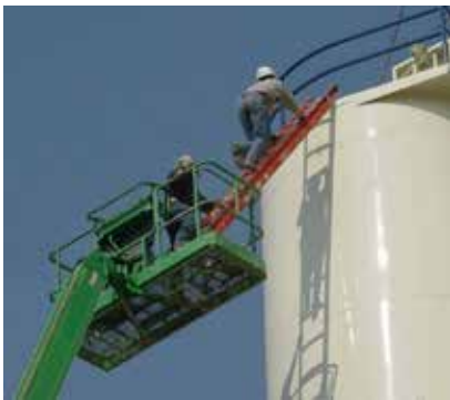
Figura 10. Acceso a una estructura utilizando medios auxiliares
