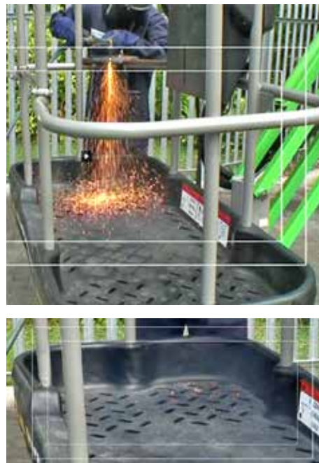
Figura 5. Base de la plataforma de trabajo autoextinguible.
