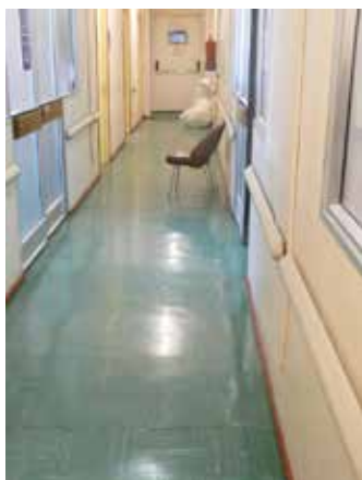
Figura 1. Ejemplos de losetas de amianto-vinilo e instalaciones (suelo y zócalo).
