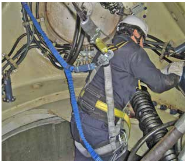
Figura 8. Trabajo en el interior del buje.
