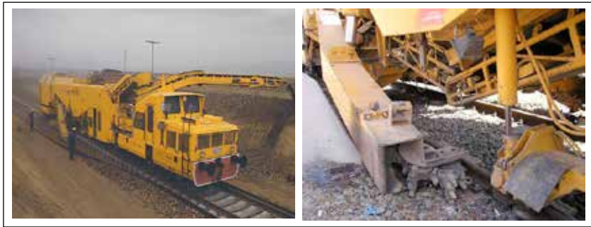
Figura 11. Desguarnecido de la vía.
