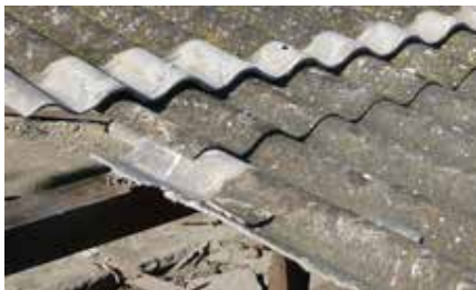
Figura 4. Placas onduladas de fibrocemento atornilladas a madera.
