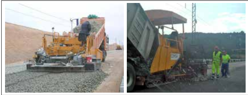
Figura 2. Actividad de extendido del balasto.
