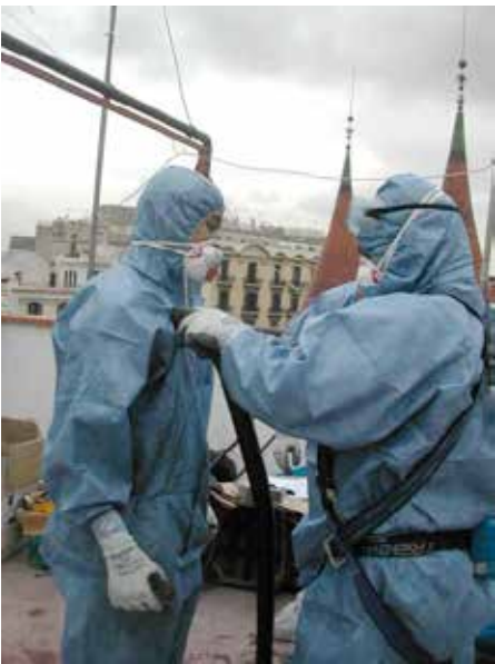
Figura 1. Aspiración previa a la descontaminación en cabina.
