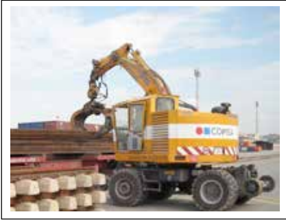
Figura 10. Retroexcavadora ferroviaria manipulando el carril.
