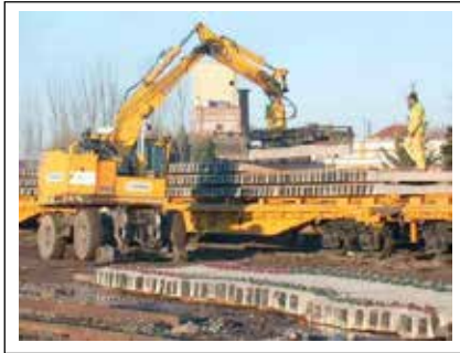
Figura 1. Descarga de las traviesas.
