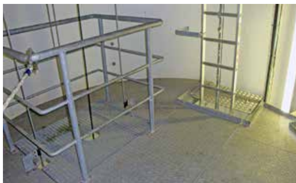
Figura 5. Plataforma intermedia con acceso por elevador y por escala.
