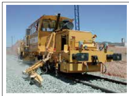
Figura 6. Perfilado del balasto.
