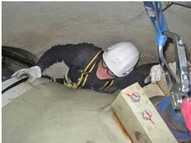
Figura 7. Acceso al interior del buje.
