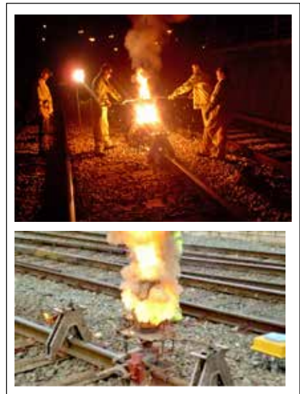
Figura 9. Reacción durante la soldadura aluminotérmica.
