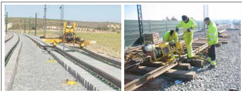
Figura 4. Posicionado y apriete del carril.
