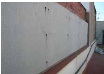
Figura 5. Placas lisas de fibrocemento atornilladas a madera.
